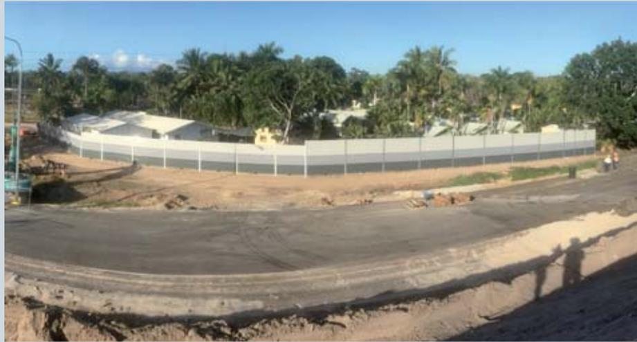
Forster Lärmschutzwände schützen die Anrainer in diesem Streckenabschnitt der Ring Road in Townsville vor Lärm.
