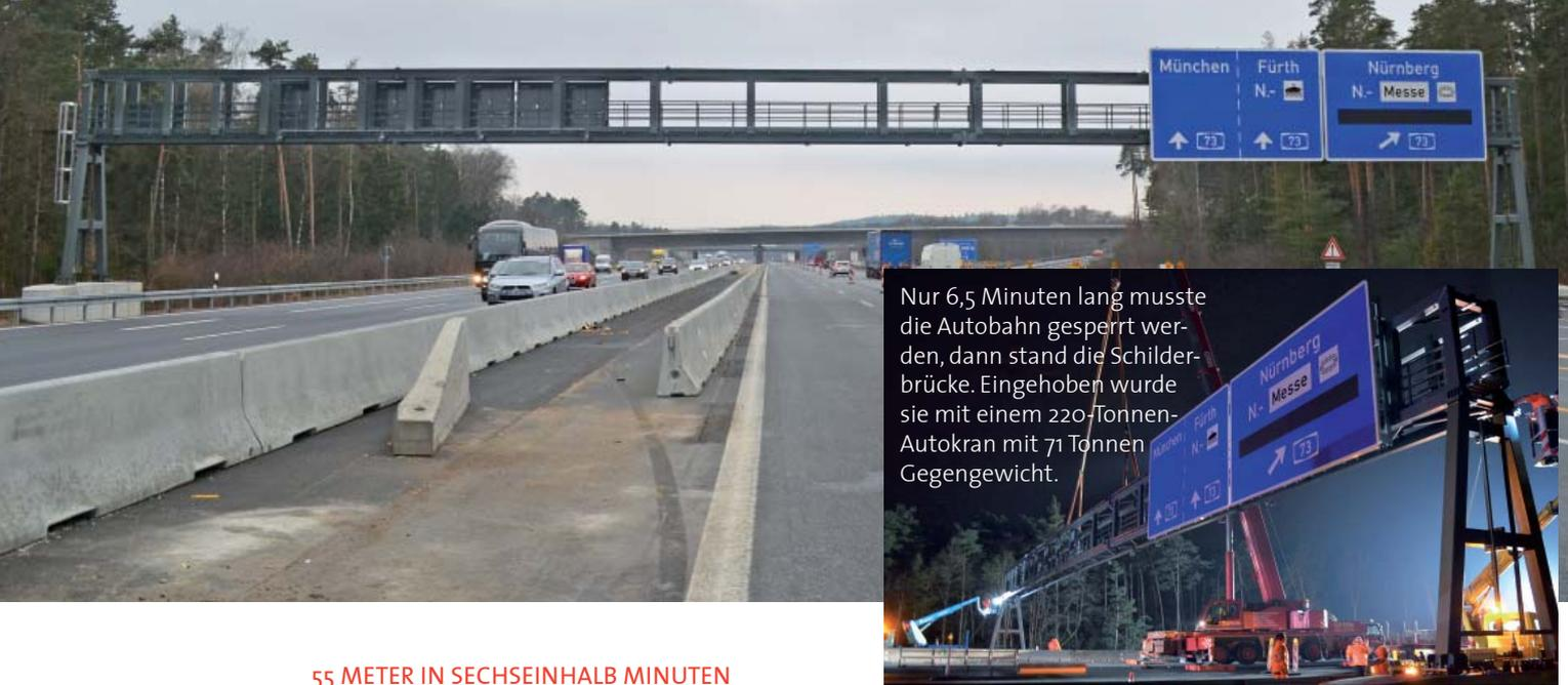
Nur 6,5 Minuten lang musste die Autobahn gesperrt werden, dann stand die Schilderbrücke. Eingehoben wurde sie mit einem 220-Tonnen-Autokran mit 71 Tonnen Gegengewicht.
