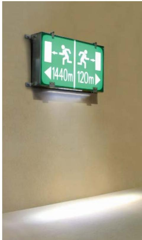
Die Evakuierungsleuchte mit High Power LED-Modulen auf der Unterseite des Schildes erleichtert die Erkennung von möglichen Hindernissen am Fluchtweg.
