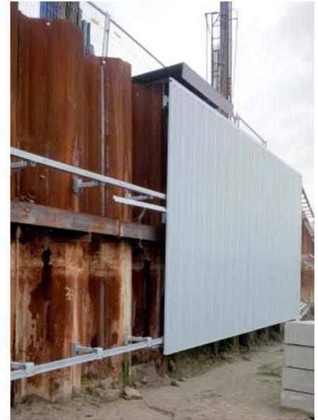
Die Schallschutzpaneele wurden mit Hilfe einer Stahlunterkonstruktion auf den Spundwänden befestigt.
